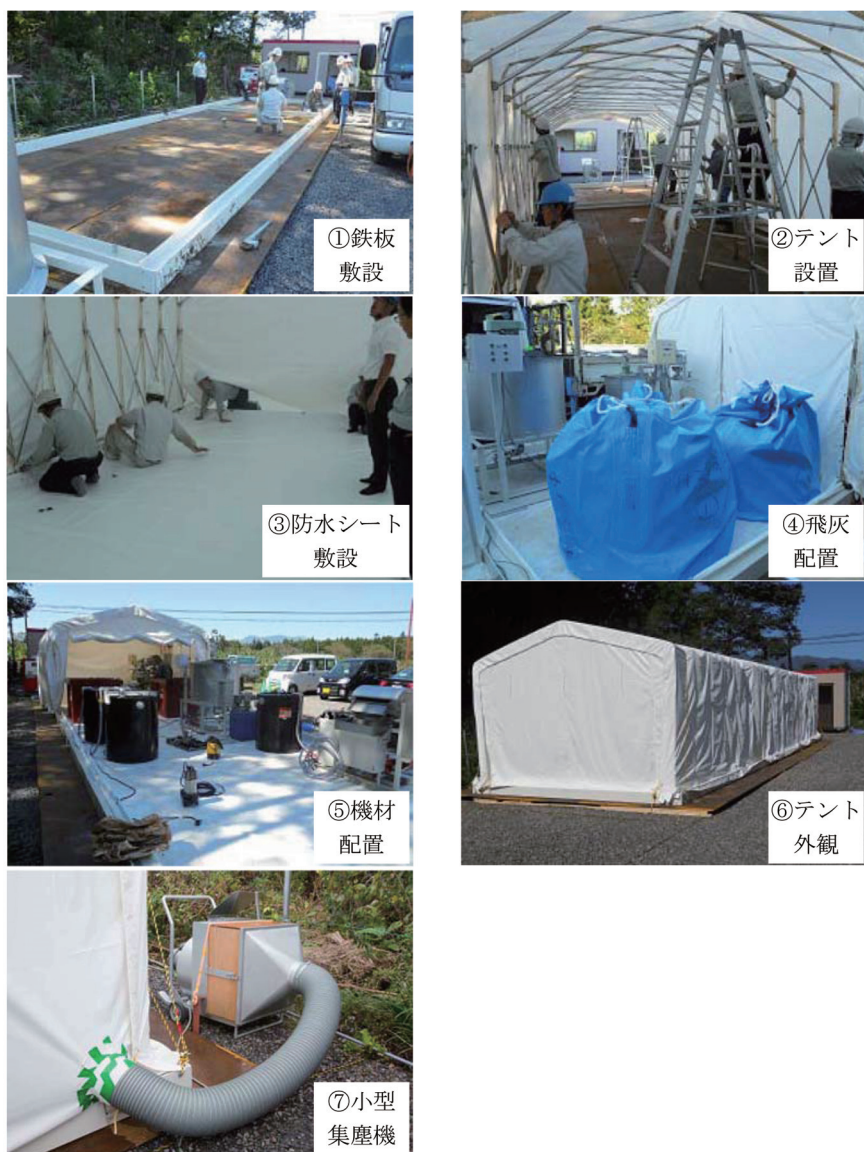
図21 試験プラントの設置工事
